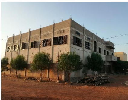
Le premier étage du lycée est terminé
