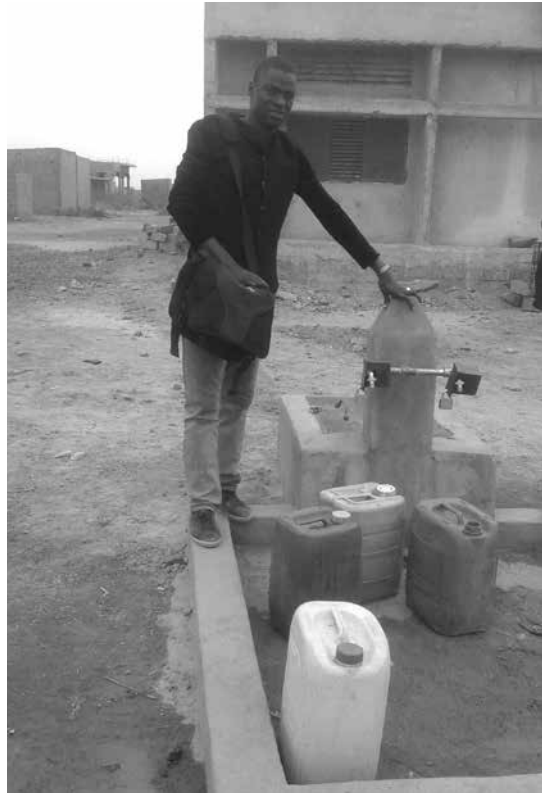
Schulleiter Ibrahim Keita beim neuen Trinkwasserbrunnen
